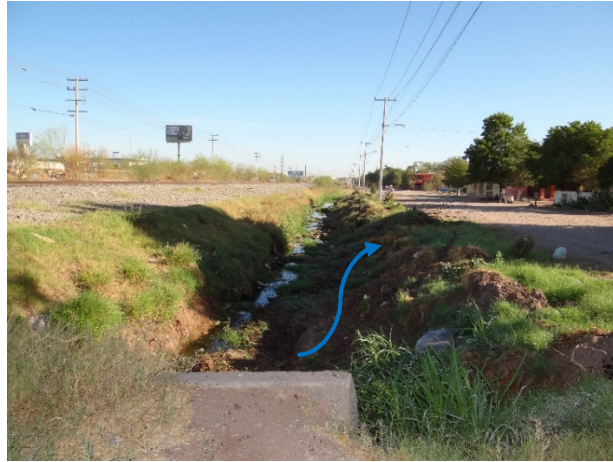
Imagen 5.1.2.5: En la Col. Matías Méndez el tubo pluvial de 90 cm de \varnothing se convierte a dren a cielo abierto y va paralelo a las vías del FFCC. Imagen en el sitio de salida viendo hacia el norte.
