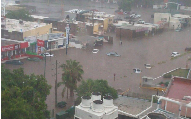
Imagen 5.3.3.2: Foto de la inundación que se presenta en la zona sobre la calle Vicente Guerrero. En la imagen se observa en la parte inferior instalaciones del IMSS y al fondo se puede ver la entrada al Parque Infantil.
