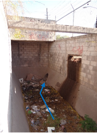
Imagen 5.1.2.4: Descarga del canal de concreto a la tubería para cruzar la calle Rosendo Montiel.
