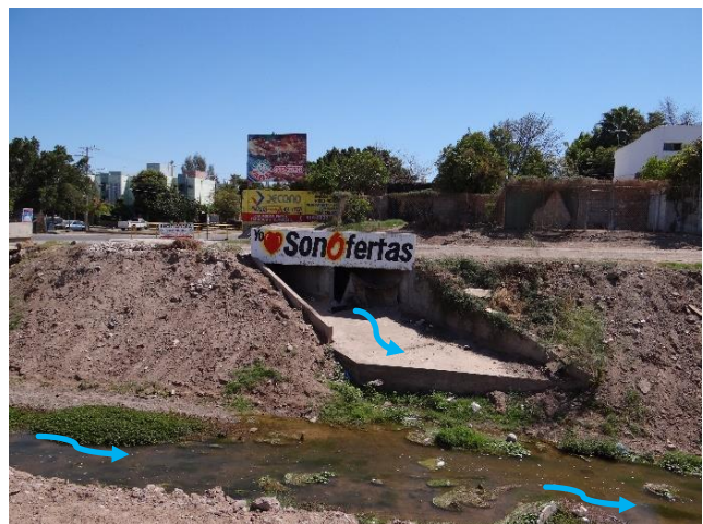
Imagen 3.2.8: Descargas pluviales del conducto hacia el Dren Bordo Prieto.
