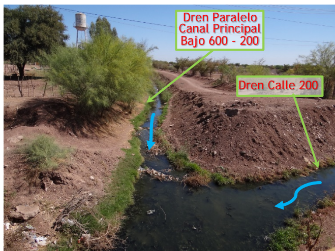
Imagen 5.5.2.2: Unión del Dren Paralelo al Canal Principal Bajo y Dren Calle 200 antes del cruce.
