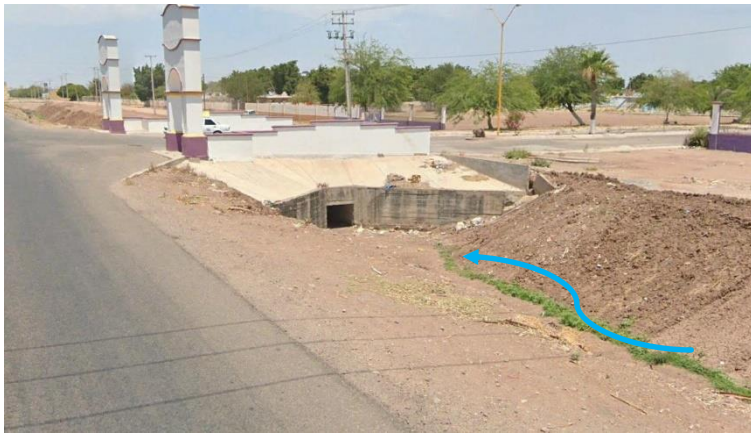
Imagen 5.4.3.3: Vista de la alcantarilla existente por abajo del puente que da acceso al fraccionamiento Real de Sevilla.
