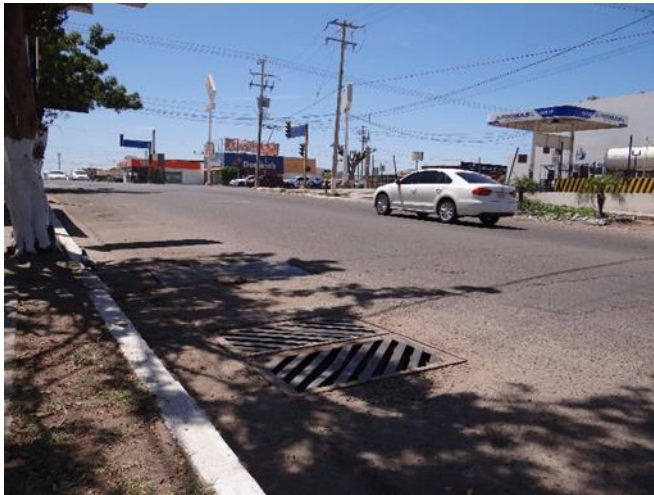
Imagen 3.3.3.4 y 3.3.3.5: Parrillas tipo ubicadas en los laterales de las vialidades con dimensiones varias.
