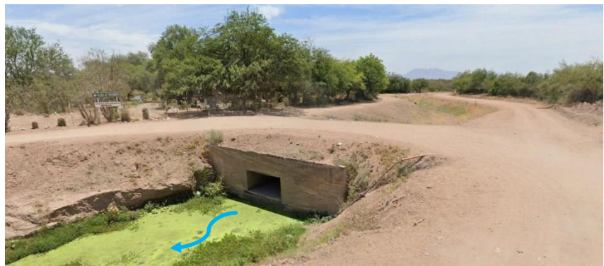
Imagen 5.2.2.4: Vista del Dren Morelos después de la estructura de cruce para entrar a la perrera municipal. Es una alcantarilla de cajón de 1.50 x 1.20 metros.
