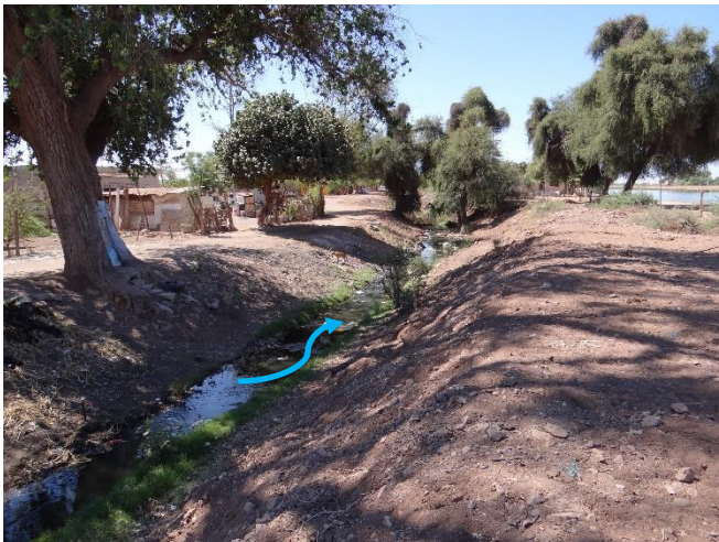
Imagen 3.2.40: Dren Paralelo al Canal Principal Bajo inmediatamente después del cruce de la Calle 200.
