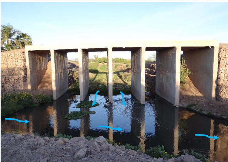
Imagen 3.2.18: Descarga del Dren Bordo Prieto al Dren Esperancita.
