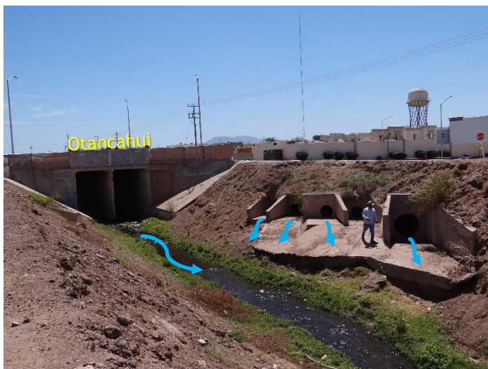
Imagen 5.2.2.2: Puente de cruce de la calle Otancahui y Dren Bordo Prieto, además de pluviales provenientes del desarrollo Puente Real.
