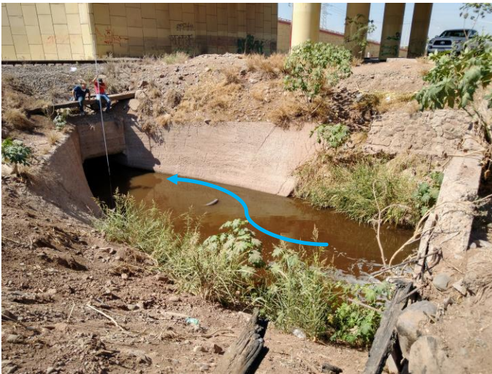
Imagen 5.4.2: Vista de la alcantarilla que pasa por debajo de las vías del ferrocarril. Esta es la estructura existente en el sitio de cruce donde confluye toda el área de la cuenca. Vista hacia el poniente.
