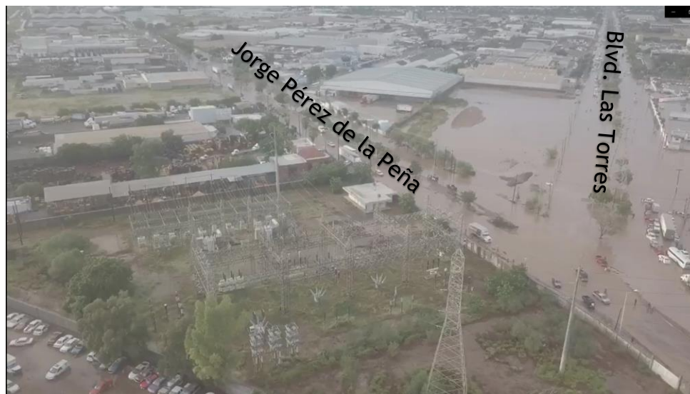
Imagen 4.1.14: Las industrias ubicadas entre las vías del ferrocarril y la calle Jorge Pérez de la Peña también presentaron encharcamientos dentro de sus propiedades.
