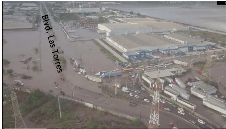
Imagen 4.1.13: Vista rumbo al norte donde se observa el Blvd. Las Torres el cual también presenta altos niveles de agua.
