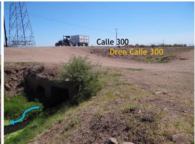
Imagen 3.2.28 y 3.2.29: Punto de descarga del Dren Calle 300 al Dren Paralelo al Canal Principal Bajo. En ambos cruces viales se observa secciones hidráulicas inadecuadas.
