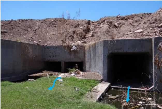
Imagen 5.2.3.3: Estructura de salida del cruce del Dren Morelos a través del Canal Principal Bajo.
