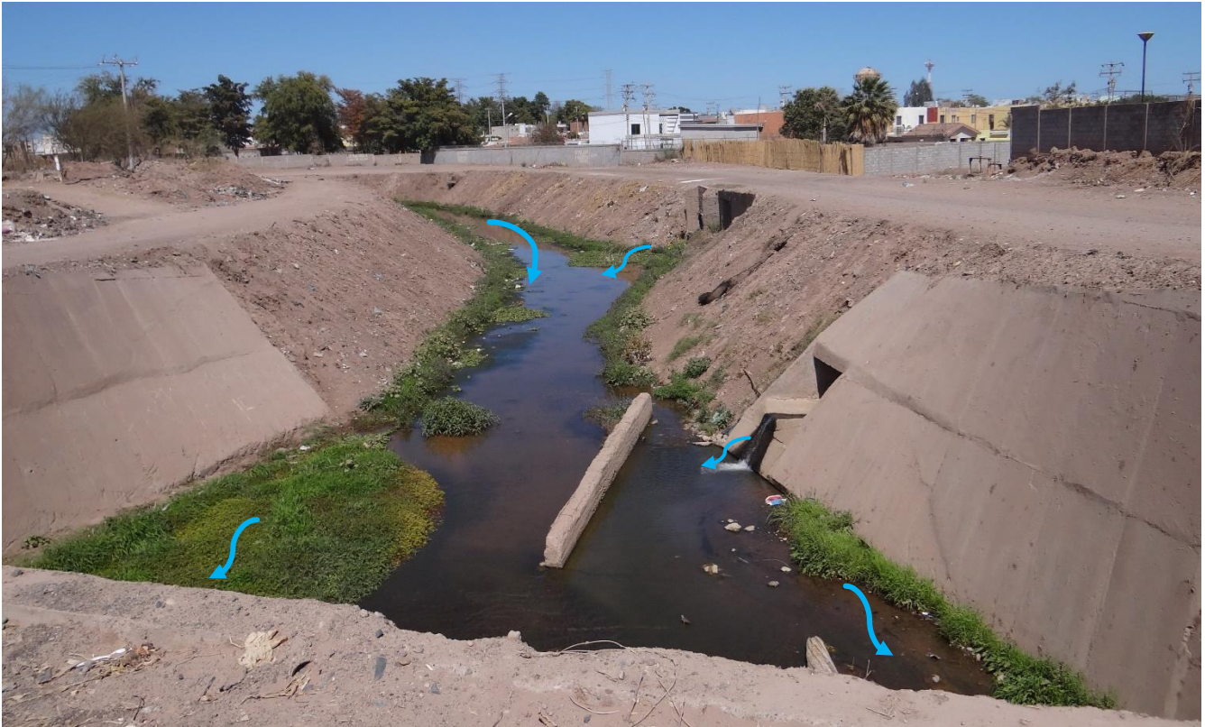
Imagen 3.4.2: Vista del Den Bordo Prieto en su llegada al Canal Principal Bajo.
