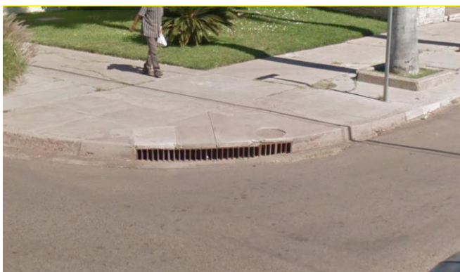
Imagen 3.3.3.8: Boca de tormenta en esquina, encontrada sobre colectores pluviales en Zona Norte.
