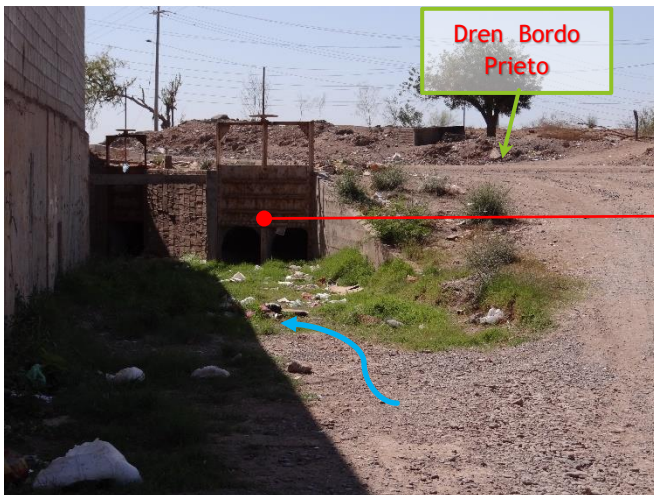
Imagen 4.1.1: Obra de descarga al Dren Bordo prieto, el agua se desplaza superficial a nivel de rasante.
