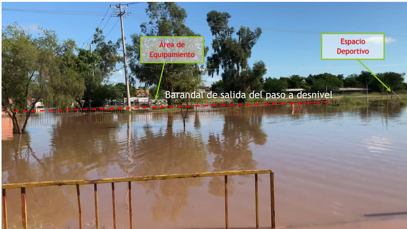
Imagen 4.1.8: Niveles de inundación lado oriente del paso a desnivel Francisco Villanueva.
