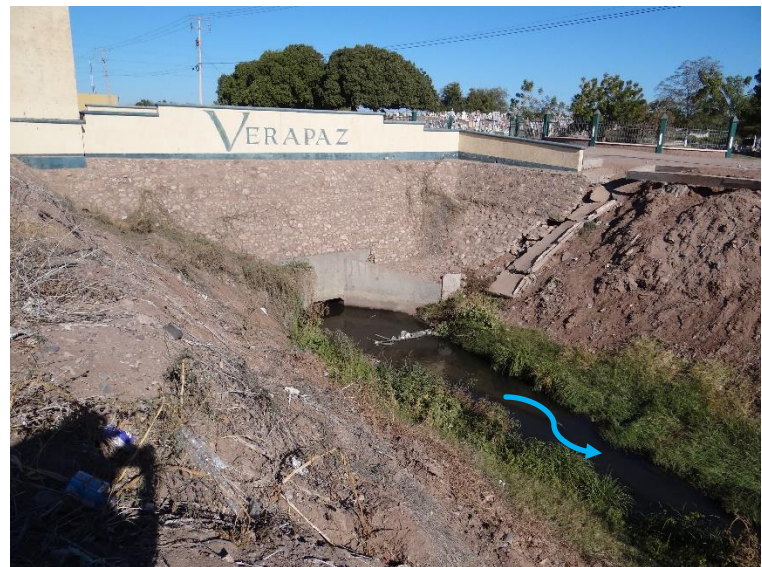
Imagen 5.4.3.11: Vista de la alcantarilla que pasa por abajo del puente que da acceso al panteón Verapaz.
