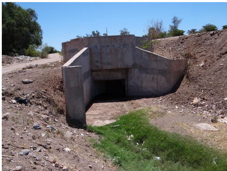
Imagen 3.4.6: Salida Oriente: Estructura de salida. Alcantarilla de 2.58 x 1.50 m.
