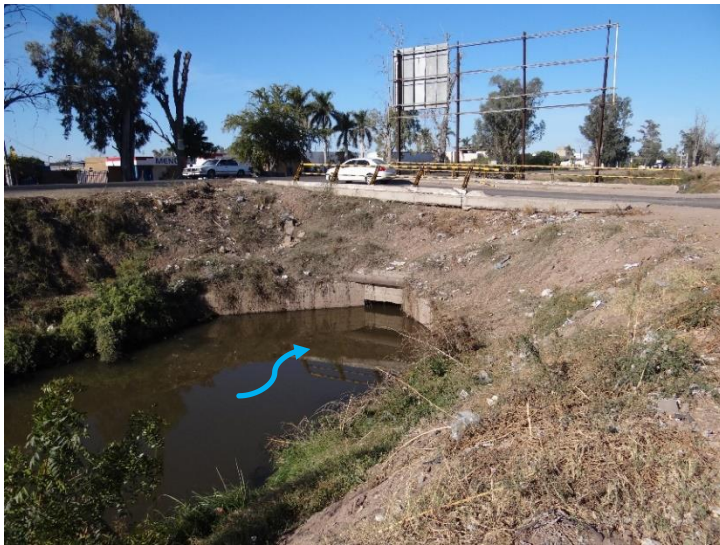
Imagen 5.4.3.10: Vista de la alcantarilla que se encuentra bajo la vialidad Bartolomé Delgado de León que es la calle que da acceso a la Colonia El Campanario. Vista hacia el oriente.
