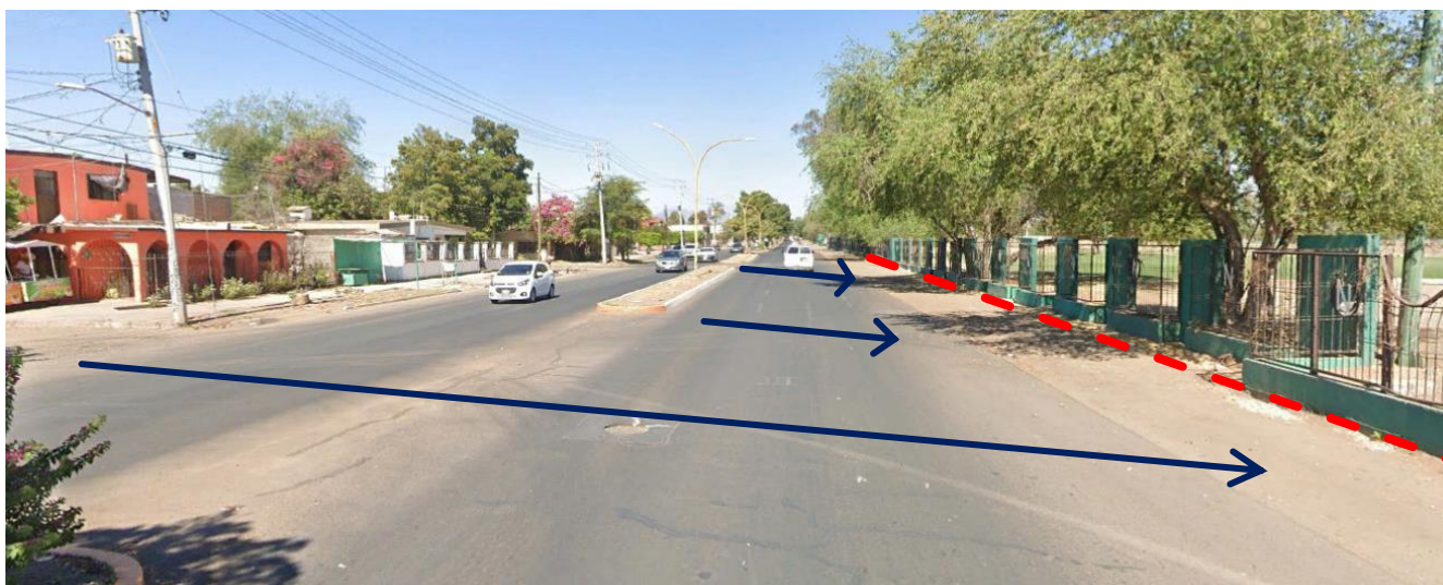
Imagen 5.3.3.12: Propuesta pluvial sobre calle José María Morelos, se propone dejar entrar el escurrimiento al área verde y deportiva.
