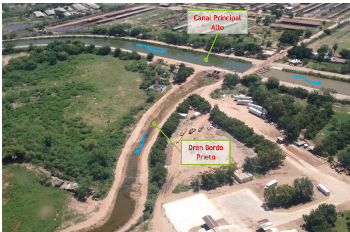
Imagen 3.2.2: Inicio del Dren Bordo Prieto en obra de toma con Canal Principal Alto.
