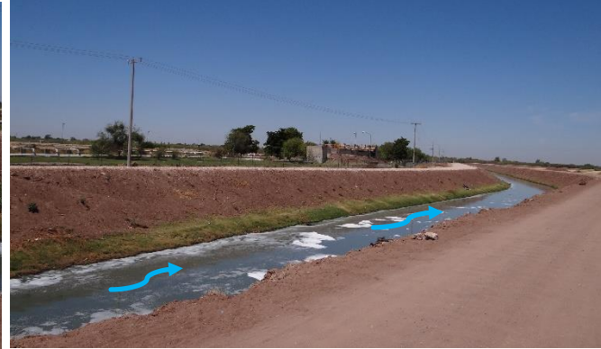
Imagen 3.2.13: El Dren presenta una sección bien definida debido a la rectificación realizada recientemente.
