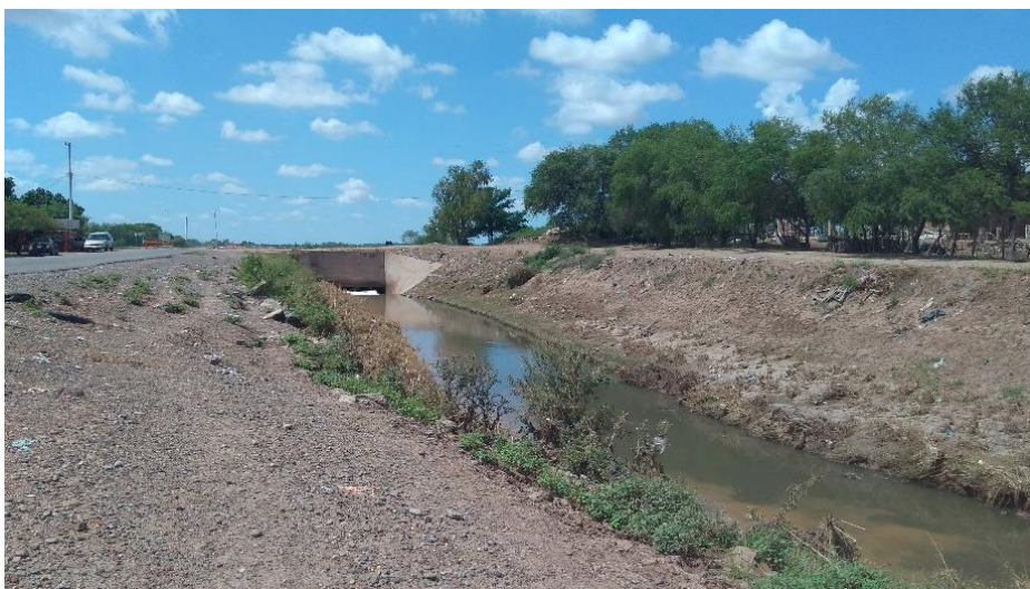
Imagen 3.4.12: Vista al poniente del Sifón Cruce # 3 Canal Principal Bajo.
