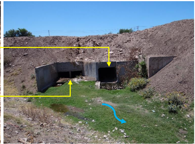
Imagen 3.4.8: Salida Poniente: Estructura de salida.
