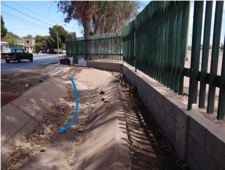
Imagen 5.3.3.9: Obra pluvial para dar salida al agua que se concentra sobre el tramo final al poniente de la calle José María Morelos.
