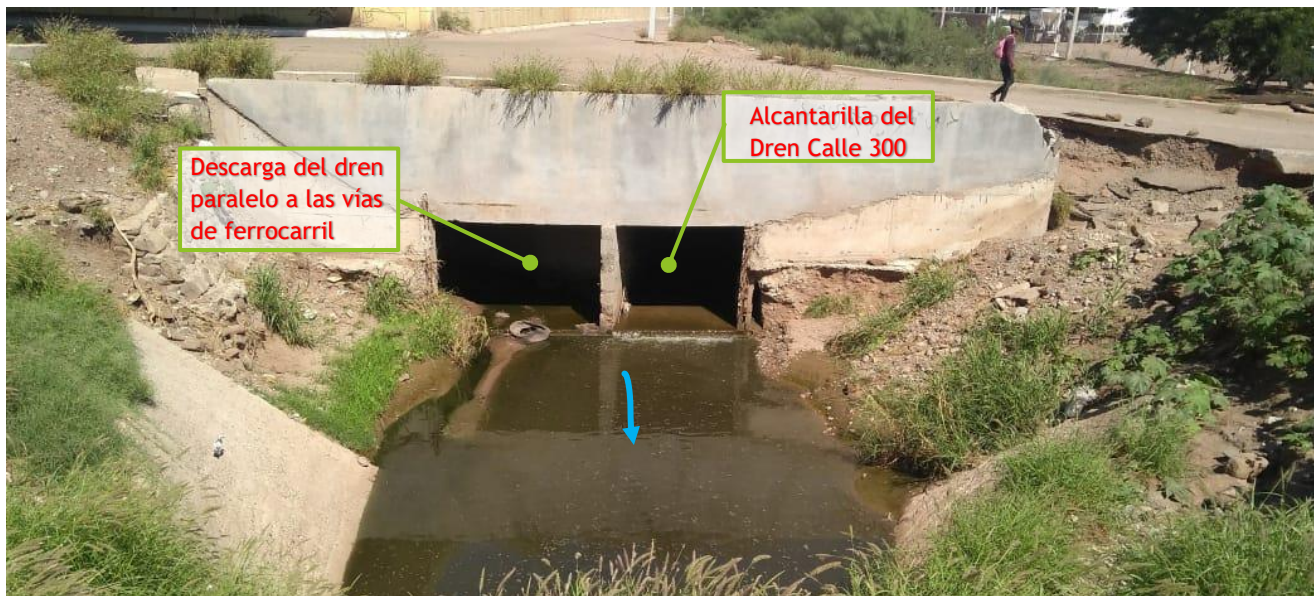
Imagen 5.4.3.25: Se observa la llegada del dren Industrial Poniente a la alcantarilla del Dren Calle 300.
