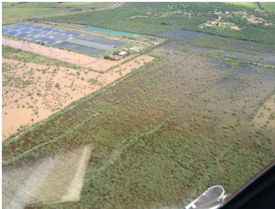
Imagen 4.1.16: Vista aérea de la zona aledaña a la planta de tratamiento después de un día de lluvia.
