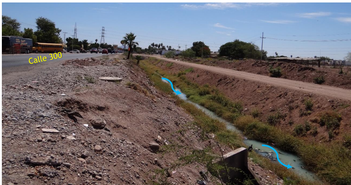
Imagen 3.2.25: Condiciones actuales del Dren Calle 300 en su tramo inicial. Se observa que ya vienen corriendo aguas negras.
