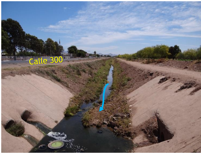
Imagen 3.2.26: Descargas de drenes de uso agrícola.
