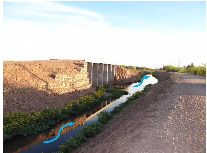
Imagen 3.2.17: Punto de descarga del Dren Morelos sobre el Dren Esperancita.
