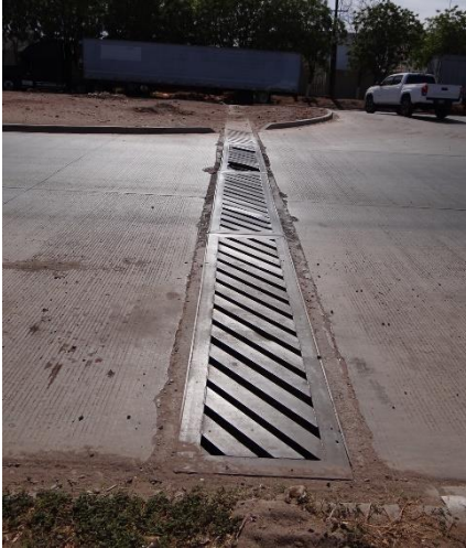
Imagen 3.3.3.2 y 3.3.3.3: Rejillas transversales ubicadas sobre el Blvd. Las Torres dentro del Parque Industrial, las cuales presentan daño estructural debido al peso de los vehículos en esta zona.
