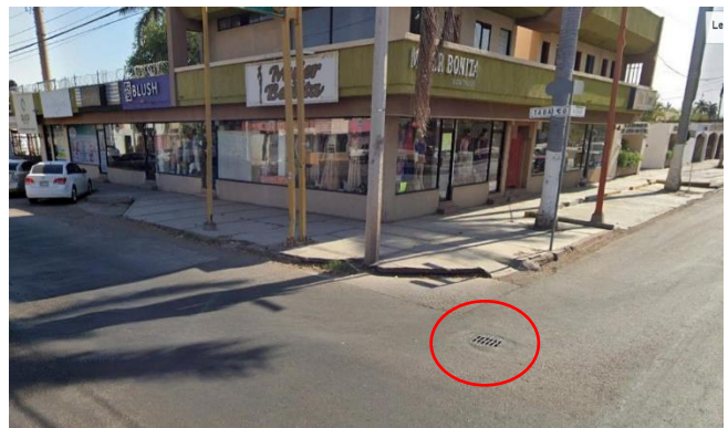
Imagen 3.3.3.9: Brocal con tapa de rejilla para pozo de visita muy común en Zona Centro de la ciudad.
