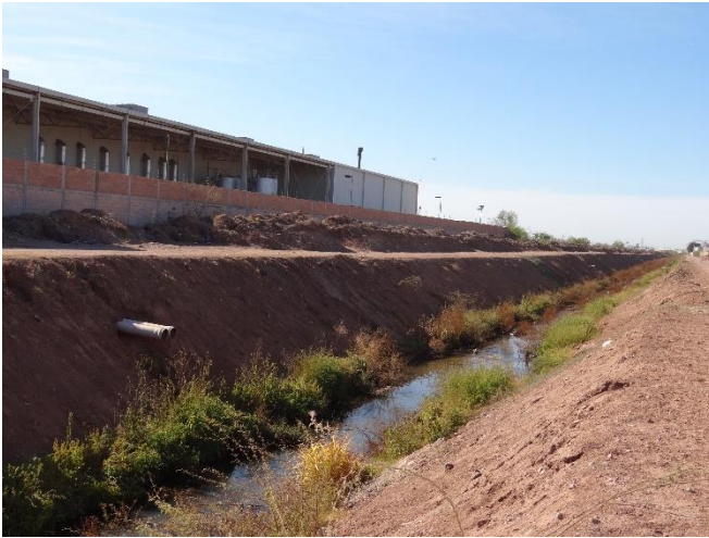
Imagen 3.2.33 y 2.3.34: Vista de la sección del dren y de las descargas conectadas tanto de uso industrial como agrícola.
