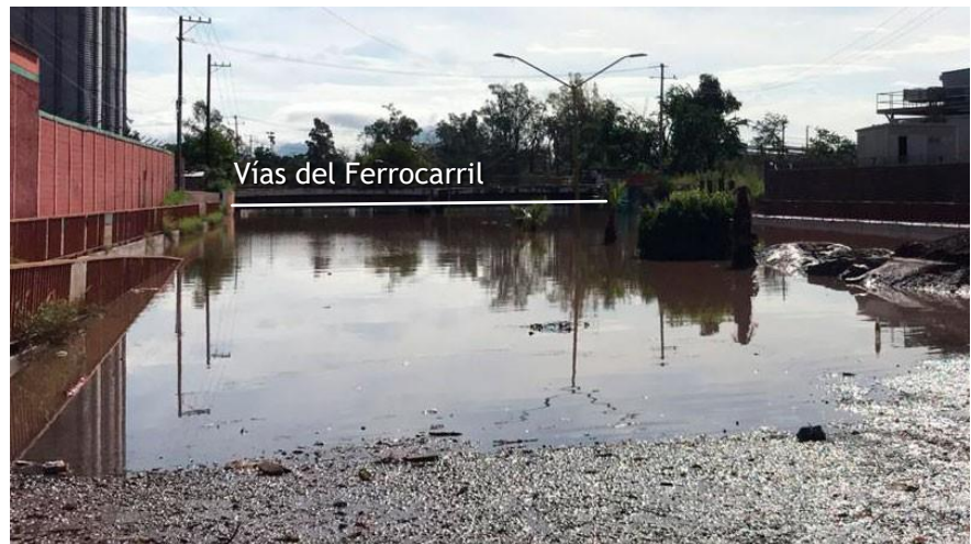
Imagen 4.1.7: Vista el oriente entrando al paso a desnivel de la Calzada Francisco Villanueva.
