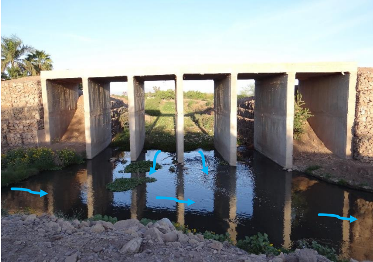
Imagen 5.2.2.5: Imagen de la llegada del Dren Bordo Prieto al Dren Esperancita.
