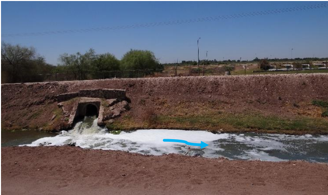
Imagen 3.2.12: Desfogue de la planta de tratamiento hacia el Dren Bordo Prieto.
