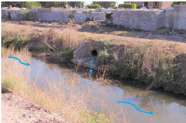
Imagen 5.4.3.8: Típica tubería de descarga pluvial que sale de las privadas de la colonia El Campanario al dren de la Calle 10.
