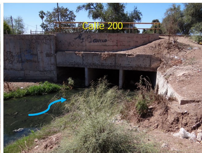
Imagen 5.5.2.3: Puente de Cruce de la Calle 200 para descargar a la subcuenca de la Calle 300 y continuar sobre el dren paralelo al Canal Principal Bajo.
