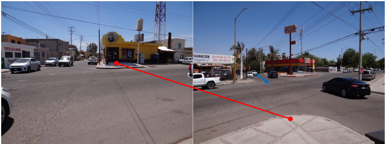
Imagen 5.3.3.6: Se muestra el cruce de la calle Otanchahui y Berna, donde se observan elevados niveles de piso terminado de los comercios con la finalidad de protegerse de los altos tirantes de
