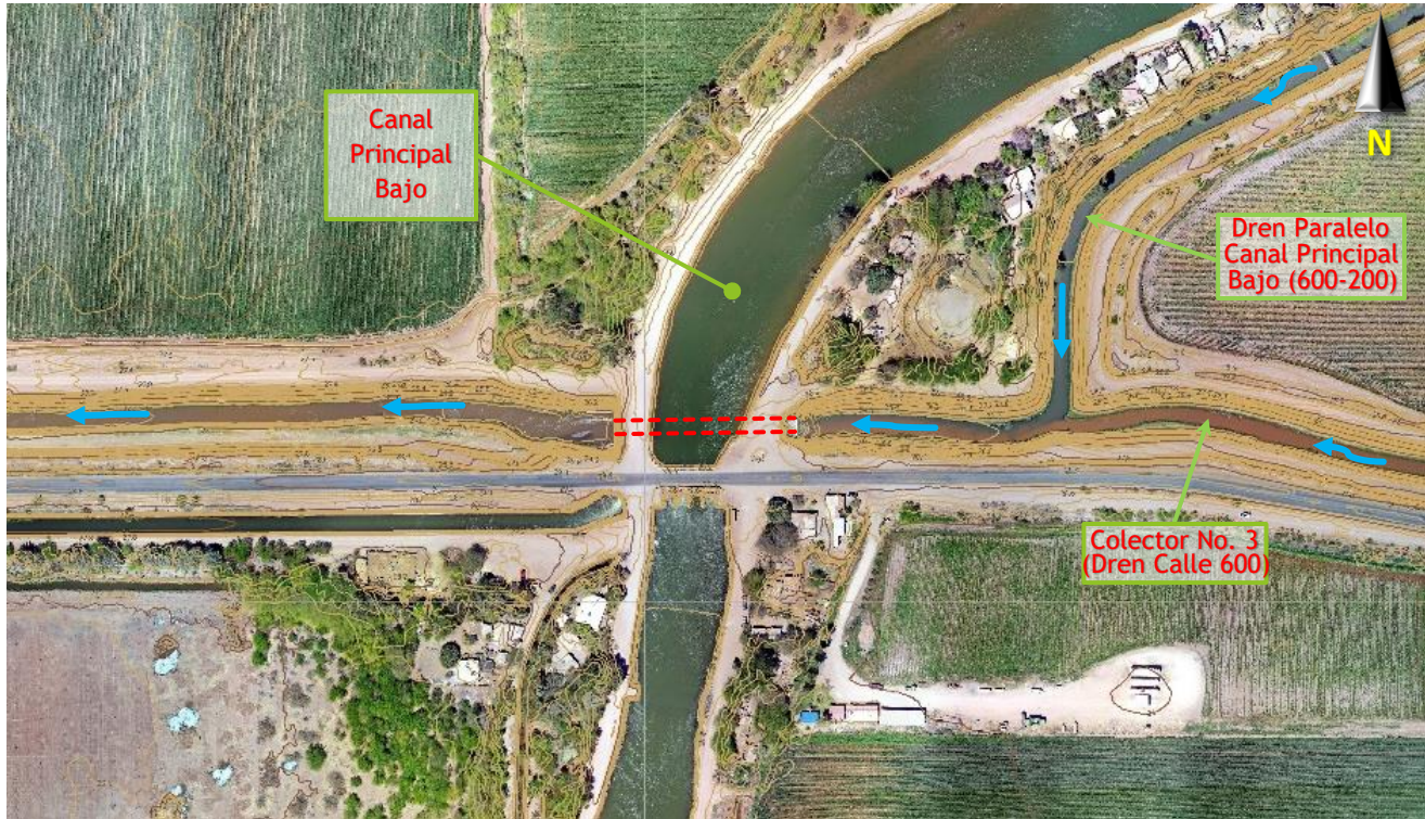
Imagen 3.4.11: Vista aérea del cruce del Dren Calle 600 con Canal Principal Bajo.
