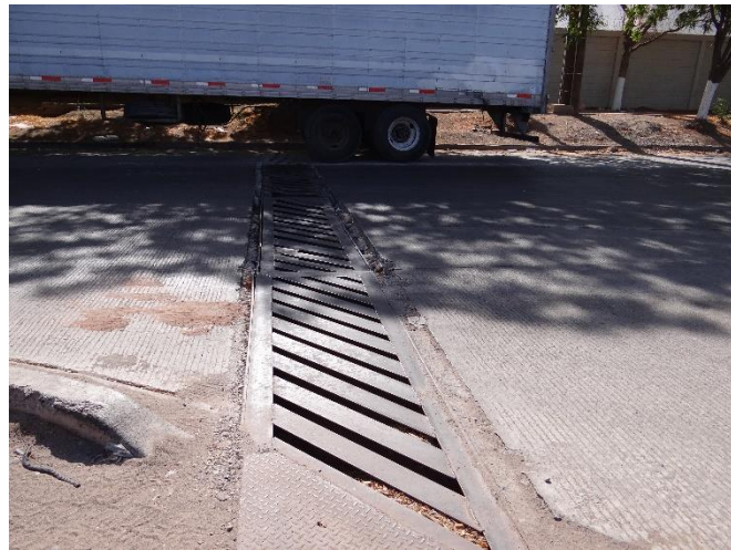
Imagen 3.3.3.2 y 3.3.3.3: Rejillas transversales ubicadas sobre el Blvd. Las Torres dentro del Parque Industrial, las cuales presentan daño estructural debido al peso de los vehículos en esta zona.
