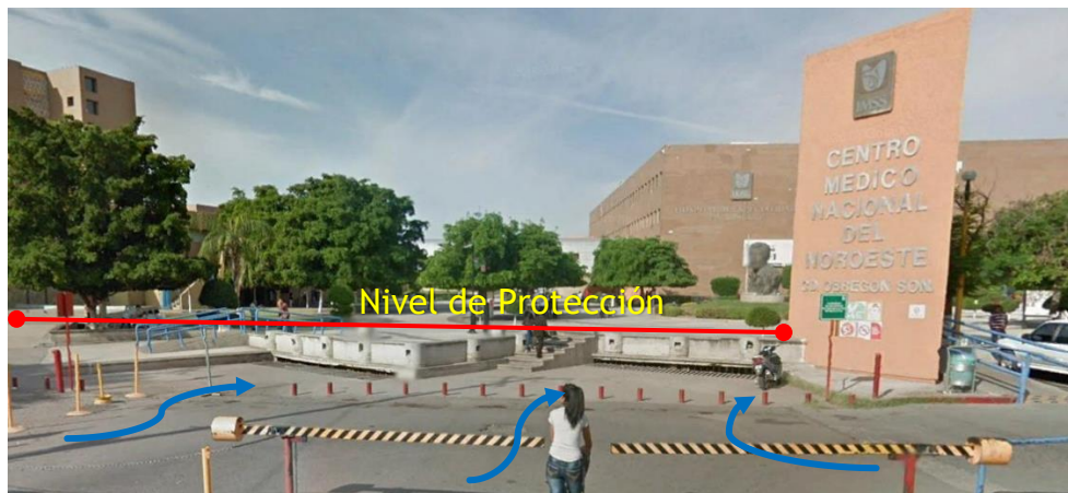
Imagen 5.3.2.7: Bocas de tormenta que dan inicio al conducto pluvial sobre la calle Miguel Hidalgo, dentro de instalaciones IMSS.
