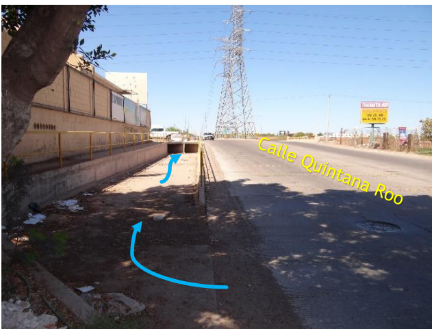
Imagen 3.2.7: Captación y conducto de descarga de la calle Quinta Roo.
