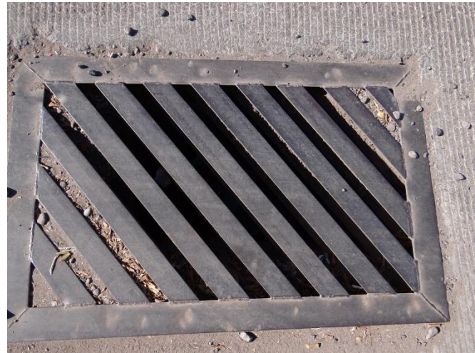
Imagen 3.3.3.4 y 3.3.3.5: Parrillas tipo ubicadas en los laterales de las vialidades con dimensiones varias.
