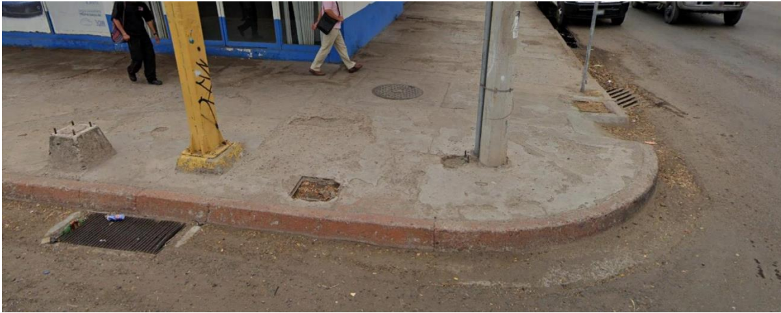
Imagen 3.3.3.6: Parilla encontrada sobre la Calle 200, sobre el tramo de la antigua bóveda entre Sufragio Efectivo y Coahuila.
