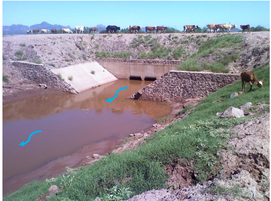
Imagen 3.4.9: Estructura de salida del sifón del Dren Calle 600.
