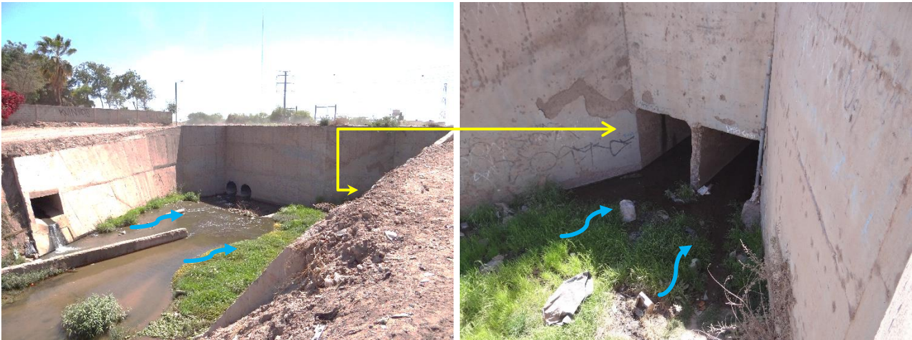
Imagen 3.4.3 y 3.4.4: Las estructuras de cruce sobre el Canal Principal Bajo.
