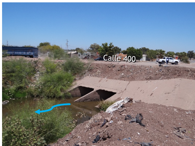
Imagen 5.5.2.18: Estructura de salida del sifón aguas abajo.
